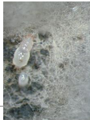
Photo 2: Acariens se délectant du mycélium d'une moisissure se développant sur un mur
